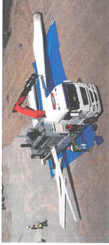
Découpe et compression des pâles de la première grande éolienne de France
